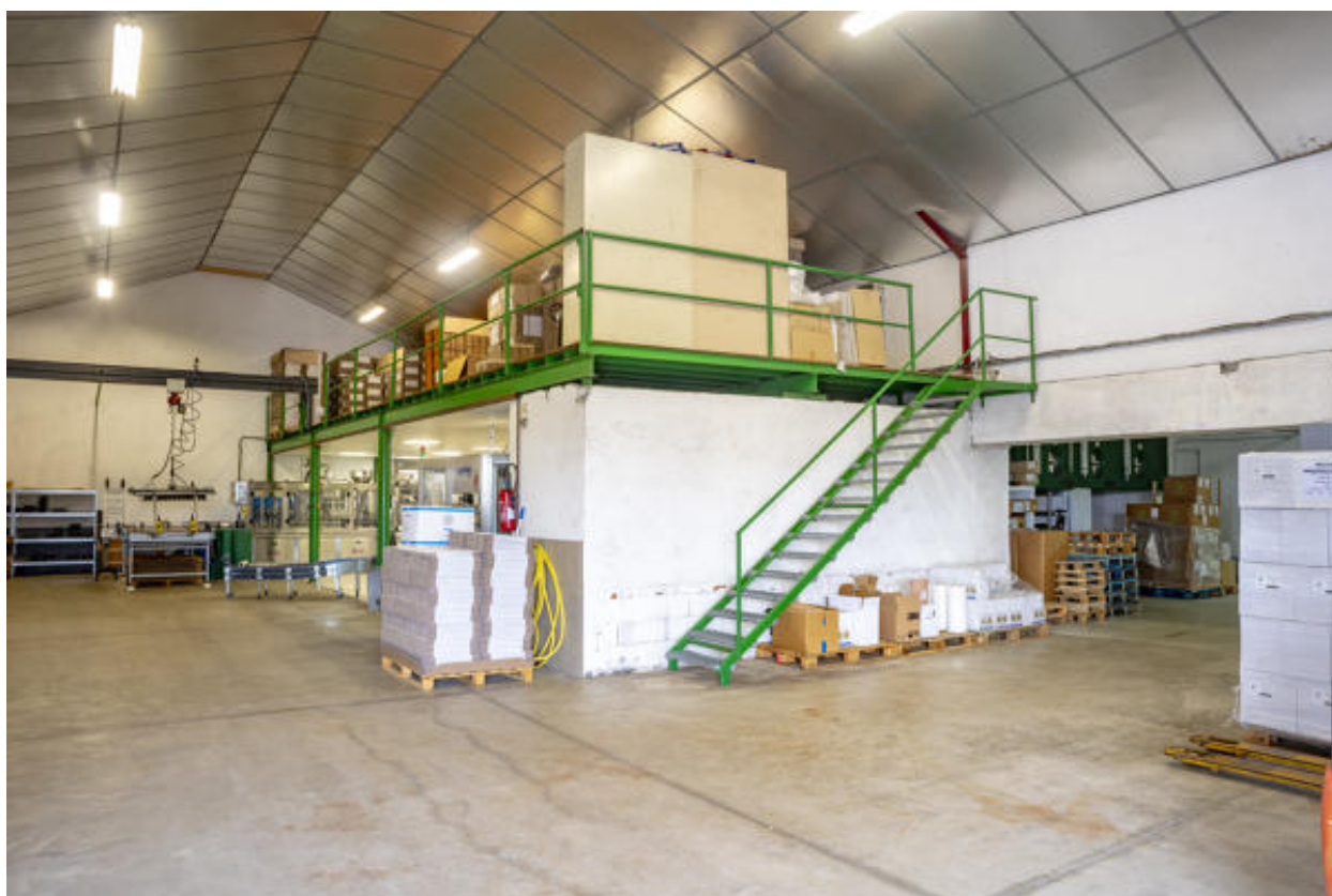
Vue générale du bâtiment primitif, depuis l'entrée.
