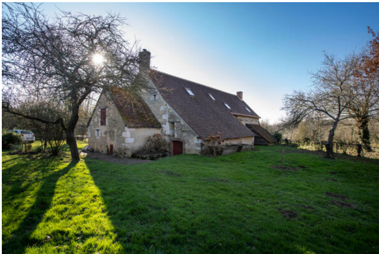
Ferme 2 : élévations postérieures du logis.
