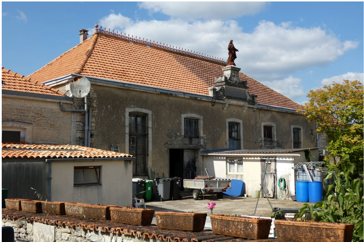
Le corps principal de bâtiment vu depuis le sud.
