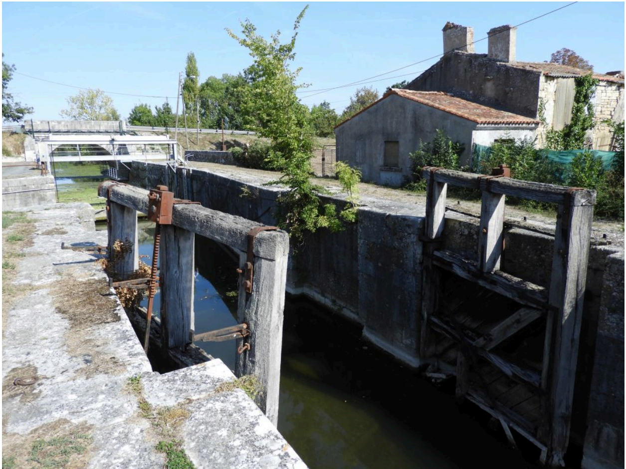
Les portes à flot encore en place à la tête amont de l'écluse, vues depuis le sud-ouest.
