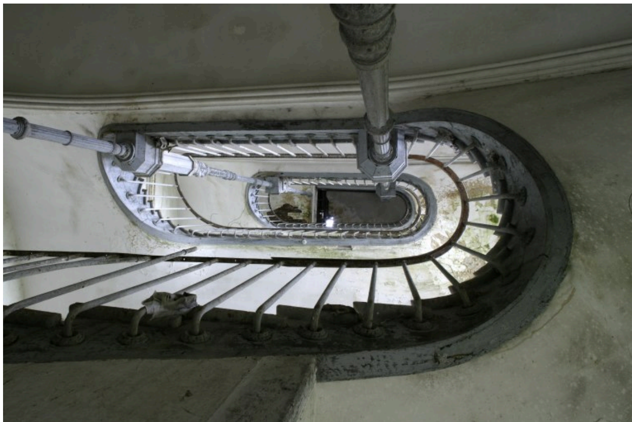
Intérieur du bâtiment principal : vue plongeante de l'escalier.
