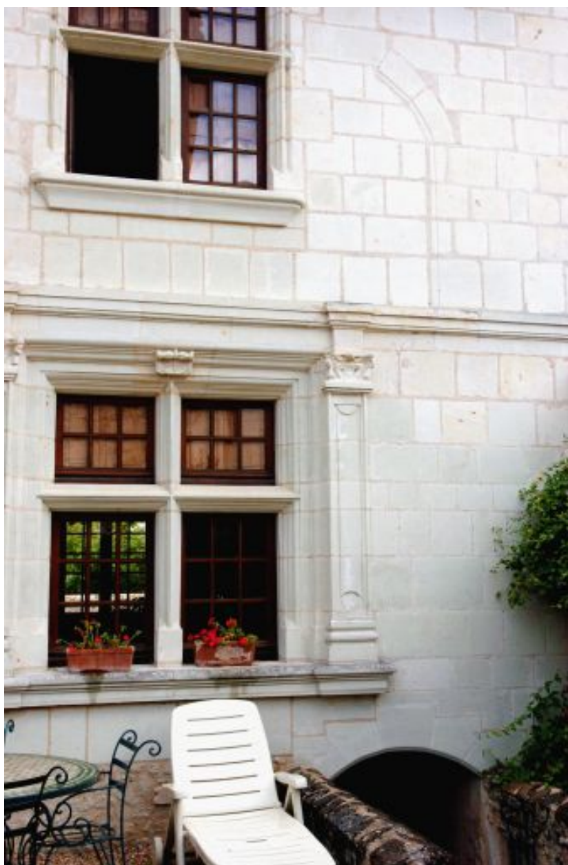
Vestiges de baie romane au premier étage.
