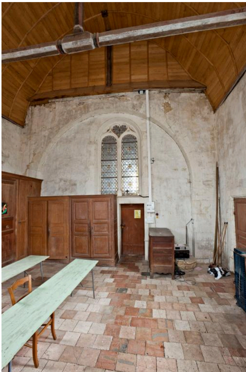
Sacristie. Arcade murée ouvrant autrefois sur le chœur.
