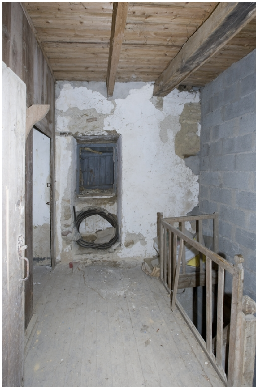
N° 10 rue Basse. Étage. Vue du palier.
