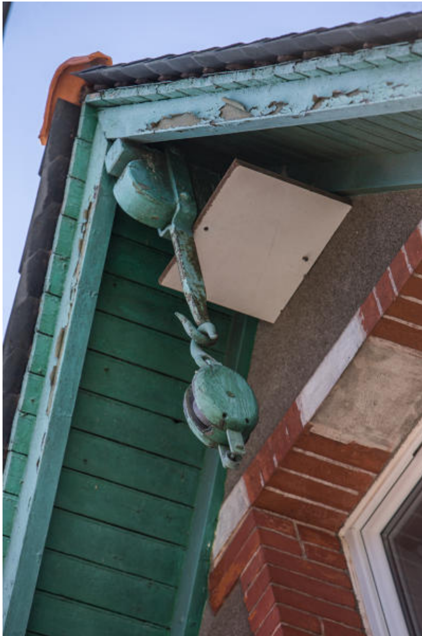
Maison, 45 rue Joseph-Tahet. Détail de la lucarne et de sa poulie.
