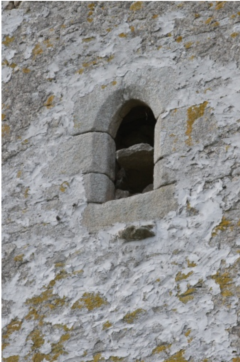
Détail de la baie du pignon est.
