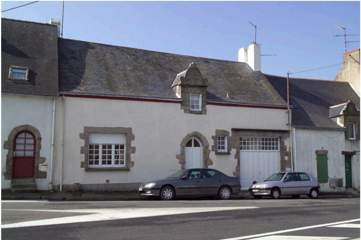
Vue de la façade sur rue.
