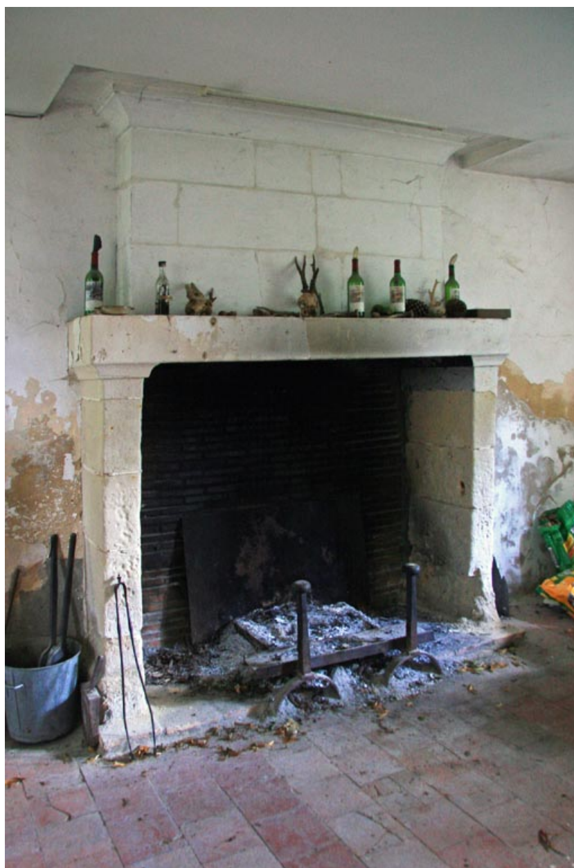
Les communs : cheminée de la 1ère salle.
