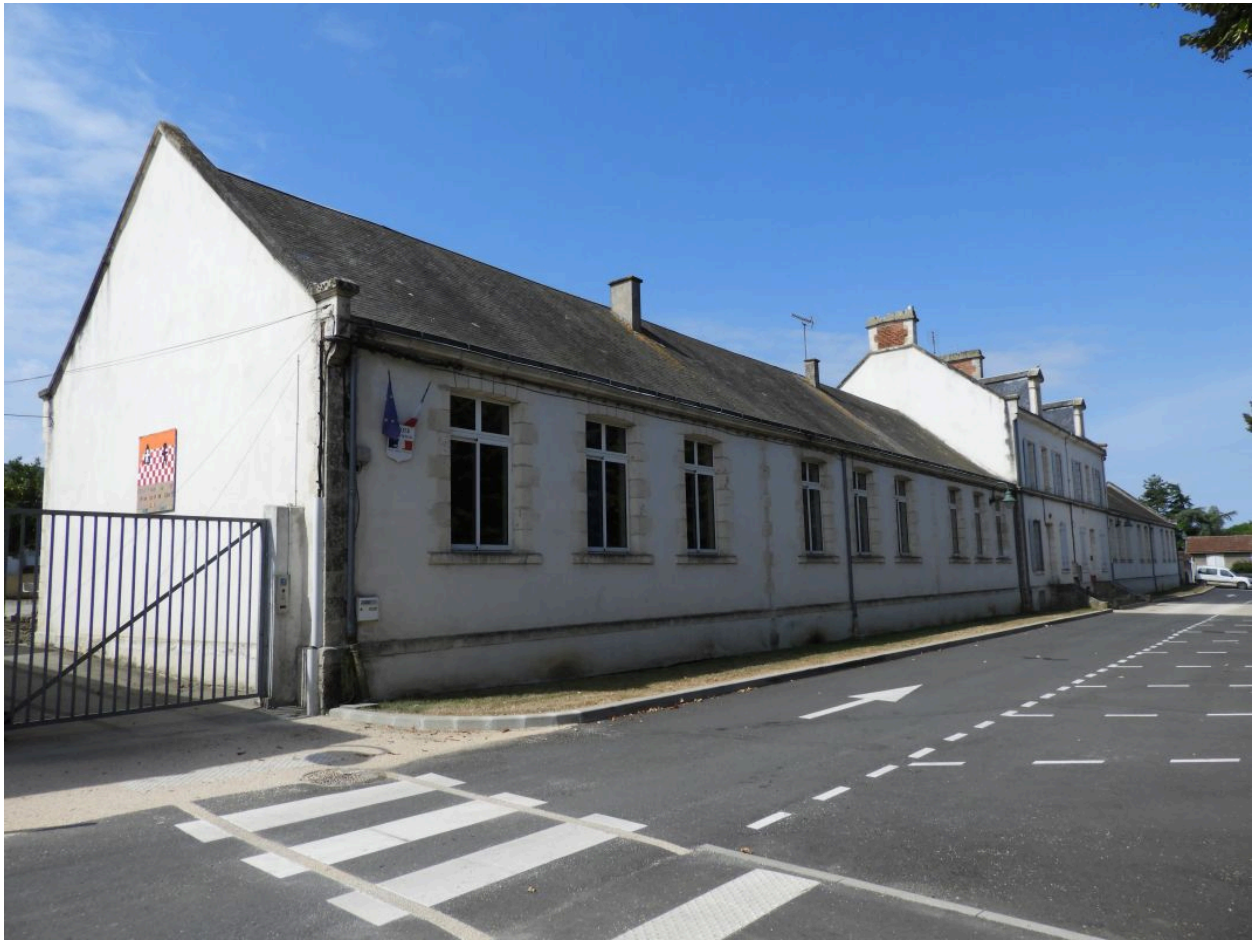
Les bâtiments de la fin du 19e siècle, parallèles à la place publique, vus depuis le nord-est.
