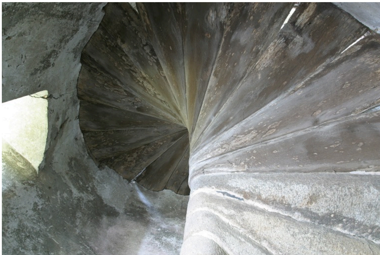
L'escalier vu de dessous.
