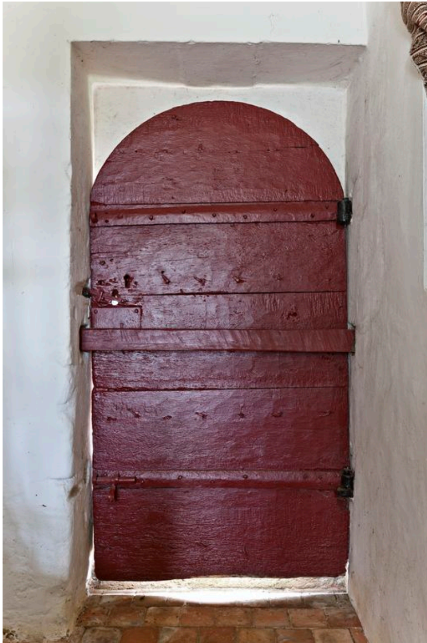
Revers de l'huissierie de la porte vers la cour avec sa barre de fermeture.
