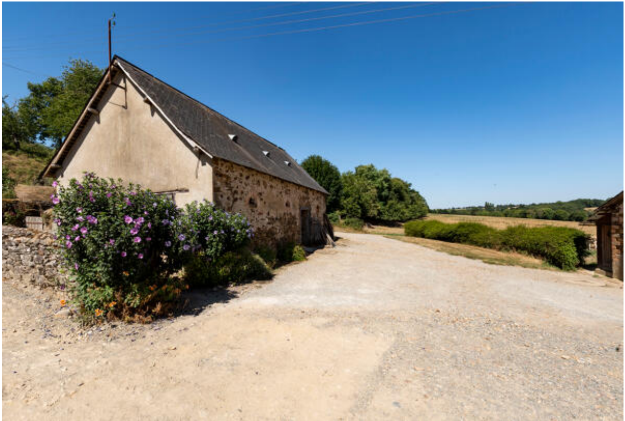
L'ancienne écurie et toits à porcs.
