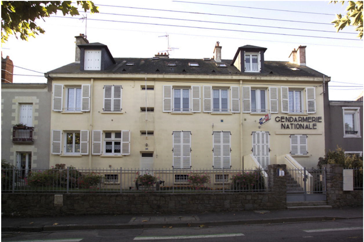
La façade sur le quai.
