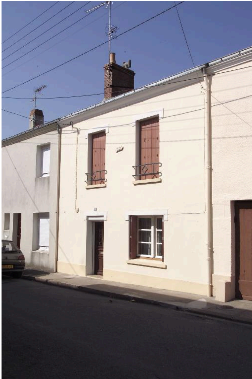
La façade antérieure de la maison n° 36 bis rue du Faisan.
