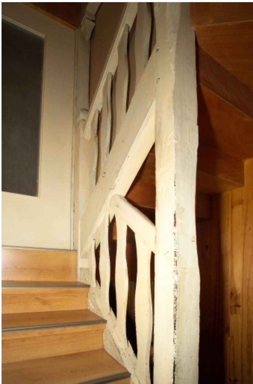
Escalier vu depuis la volée entre le rez-de-chaussée et le premier étage.
