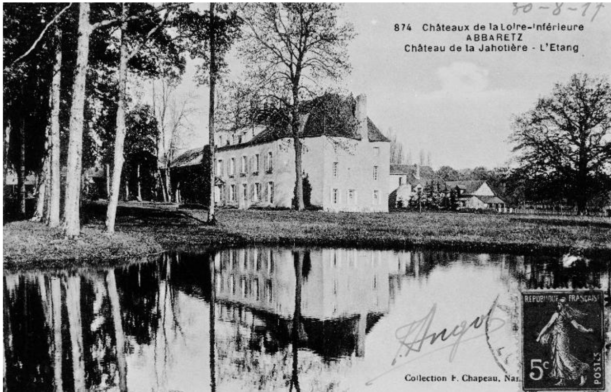
Maison de maître, logis des XVI-XVIIe siècles, façade ouest (1917).
