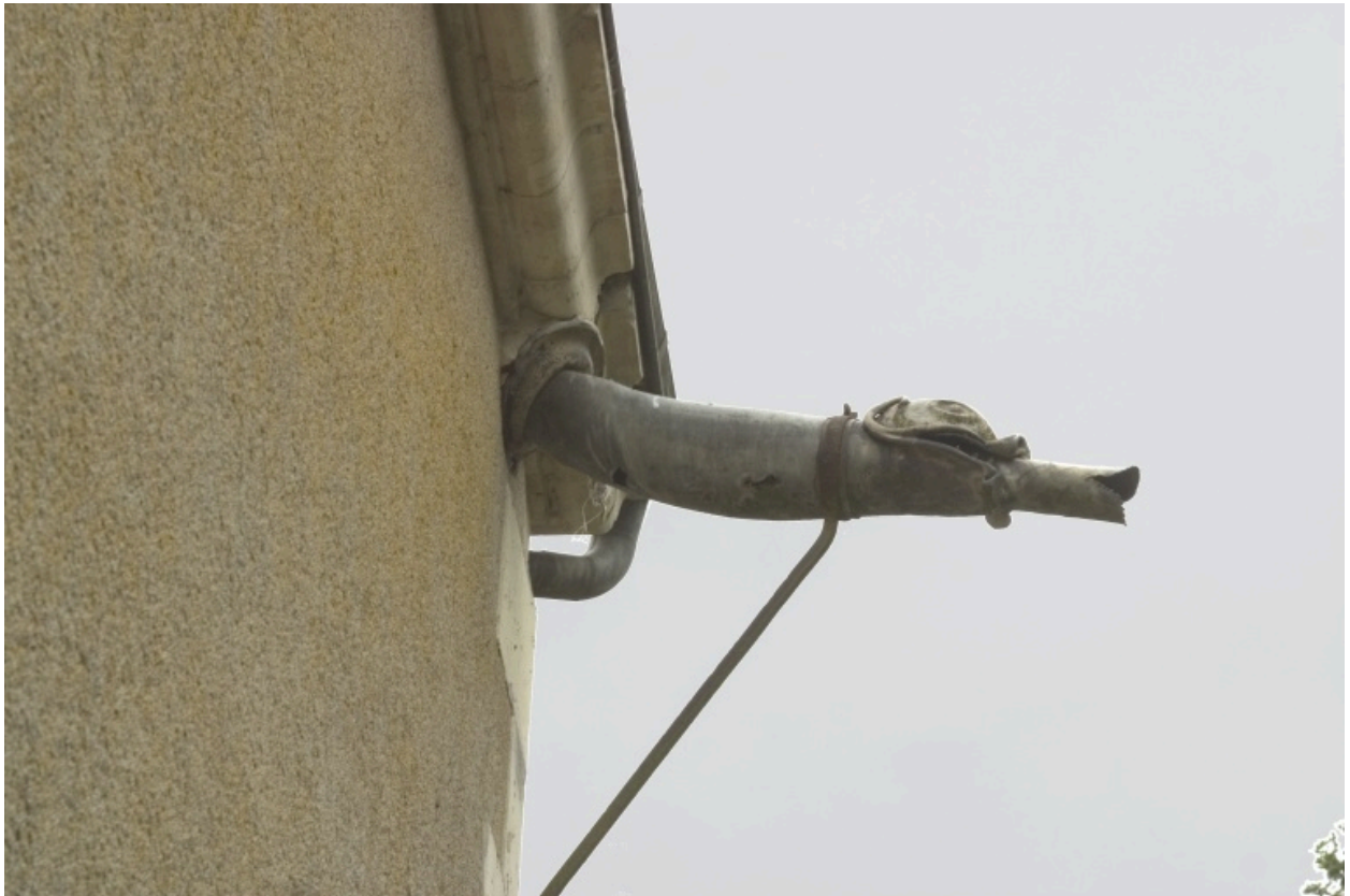
Chapelle : gargouille nord du mur est.
