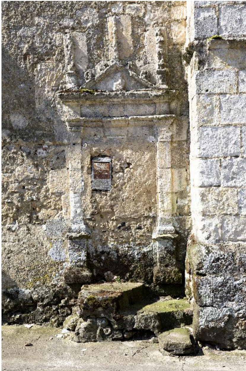
Nef, mur nord : petite entrée murée.
