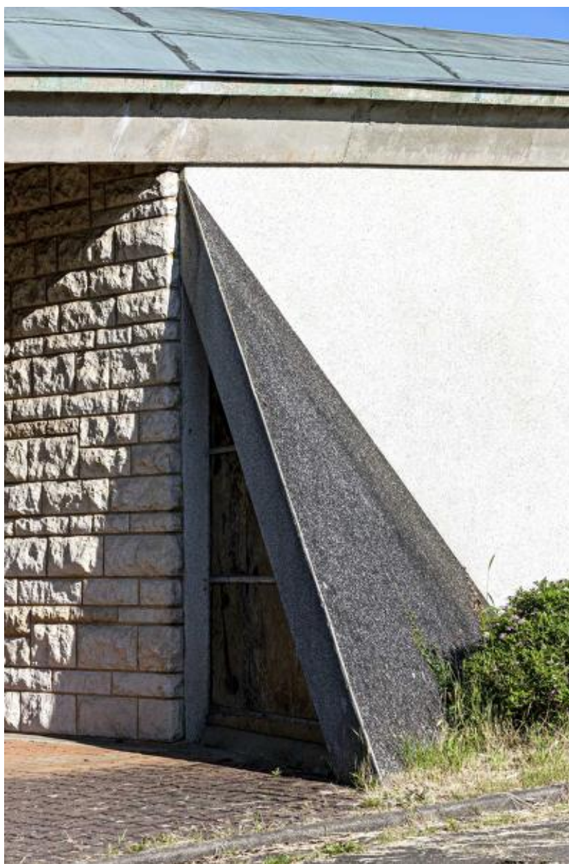
Vue d'une ouverture depuis l'extérieur.
