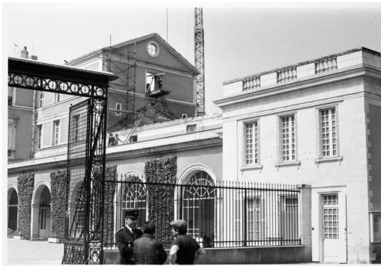
Aile ouest sur la cour d'honneur, pendant travaux : vue sur la cour, depuis le portail d'entrée.
