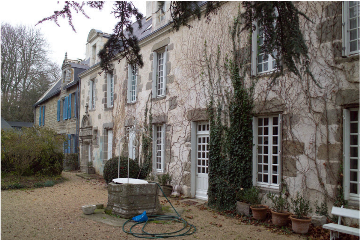
Vue générale de la façade sud.
