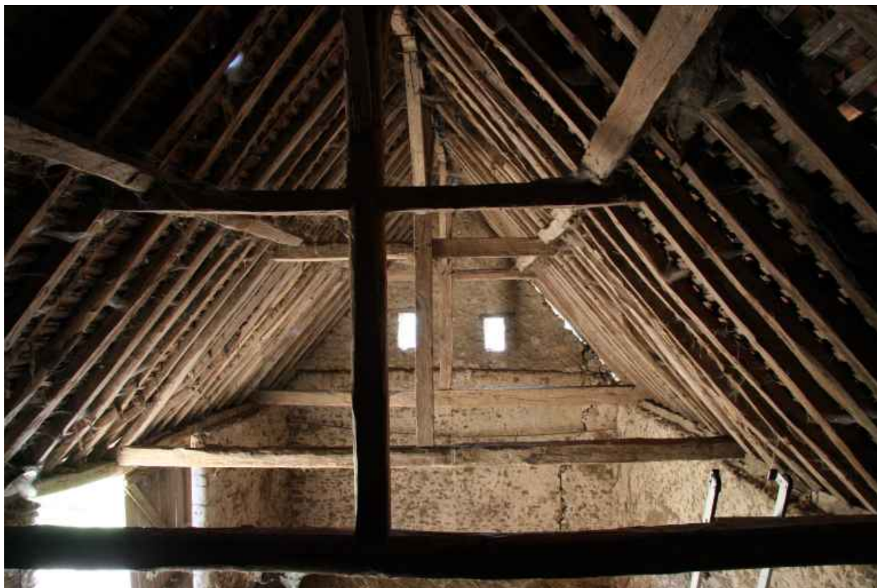
Charpente de la grange : faux-entrails à encoches.
