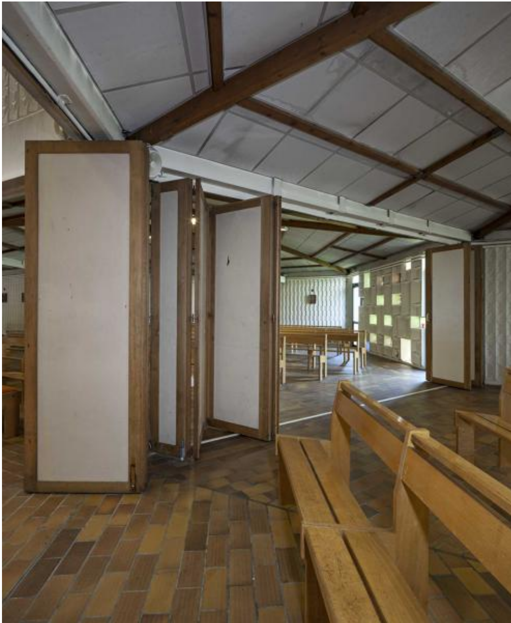
Vue de cloisons mobiles ouvertes.
