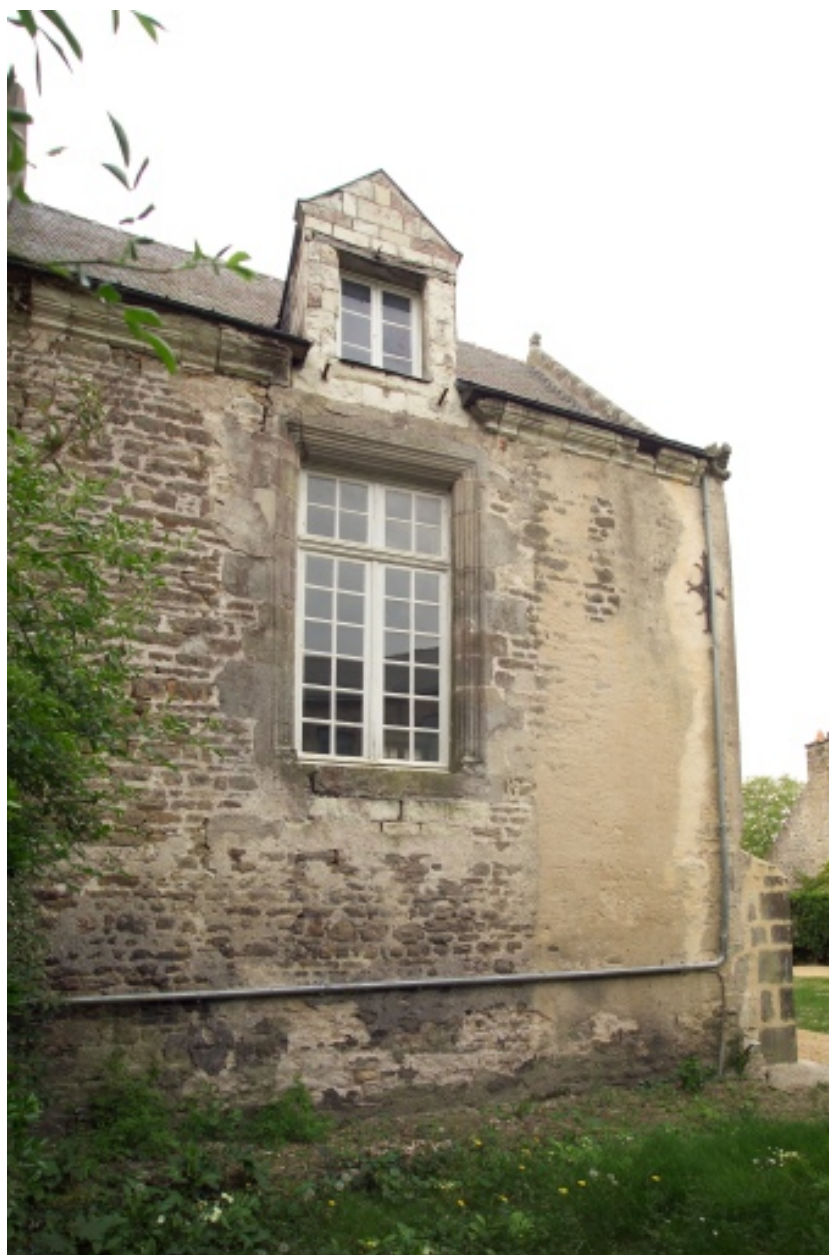
Vue du bâtiment du XVI e siècle, façade en retrait de la rue.
