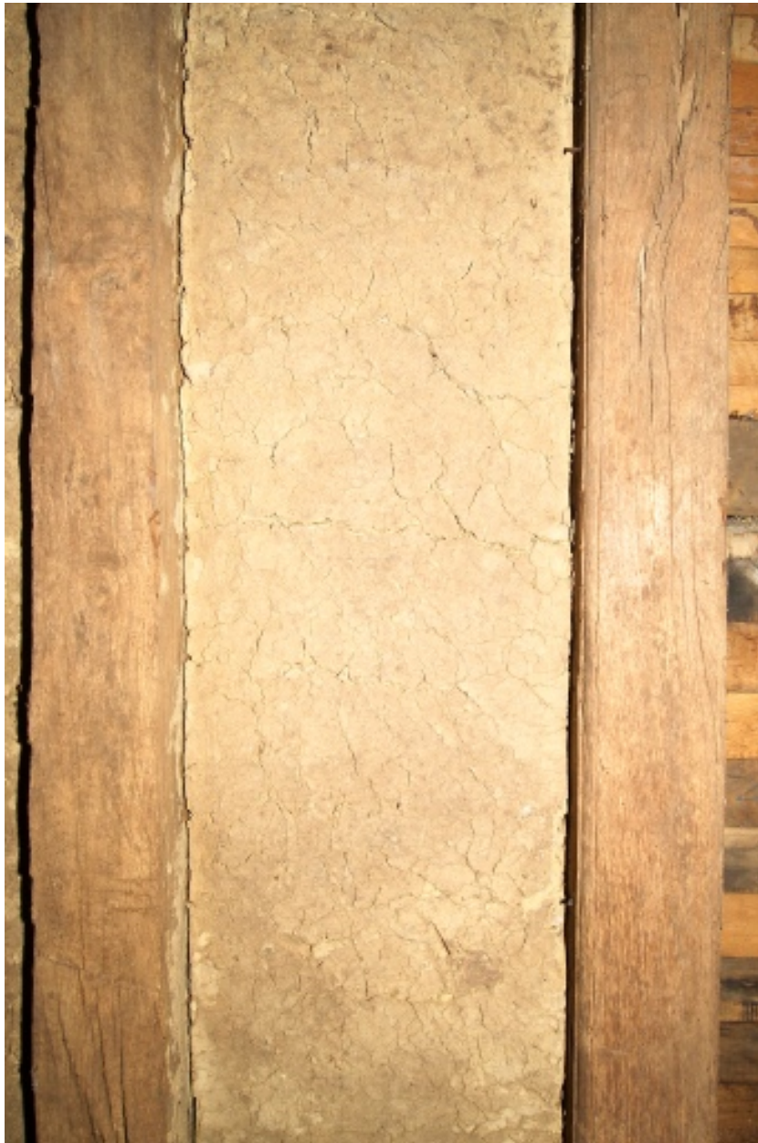
Détail de bousillis entre les solives du plancher du rez-de-chaussée vu depuis la cave.
