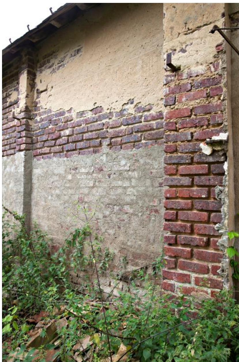
Dépendance 1 : détail de la mise en œuvre de la brique.
