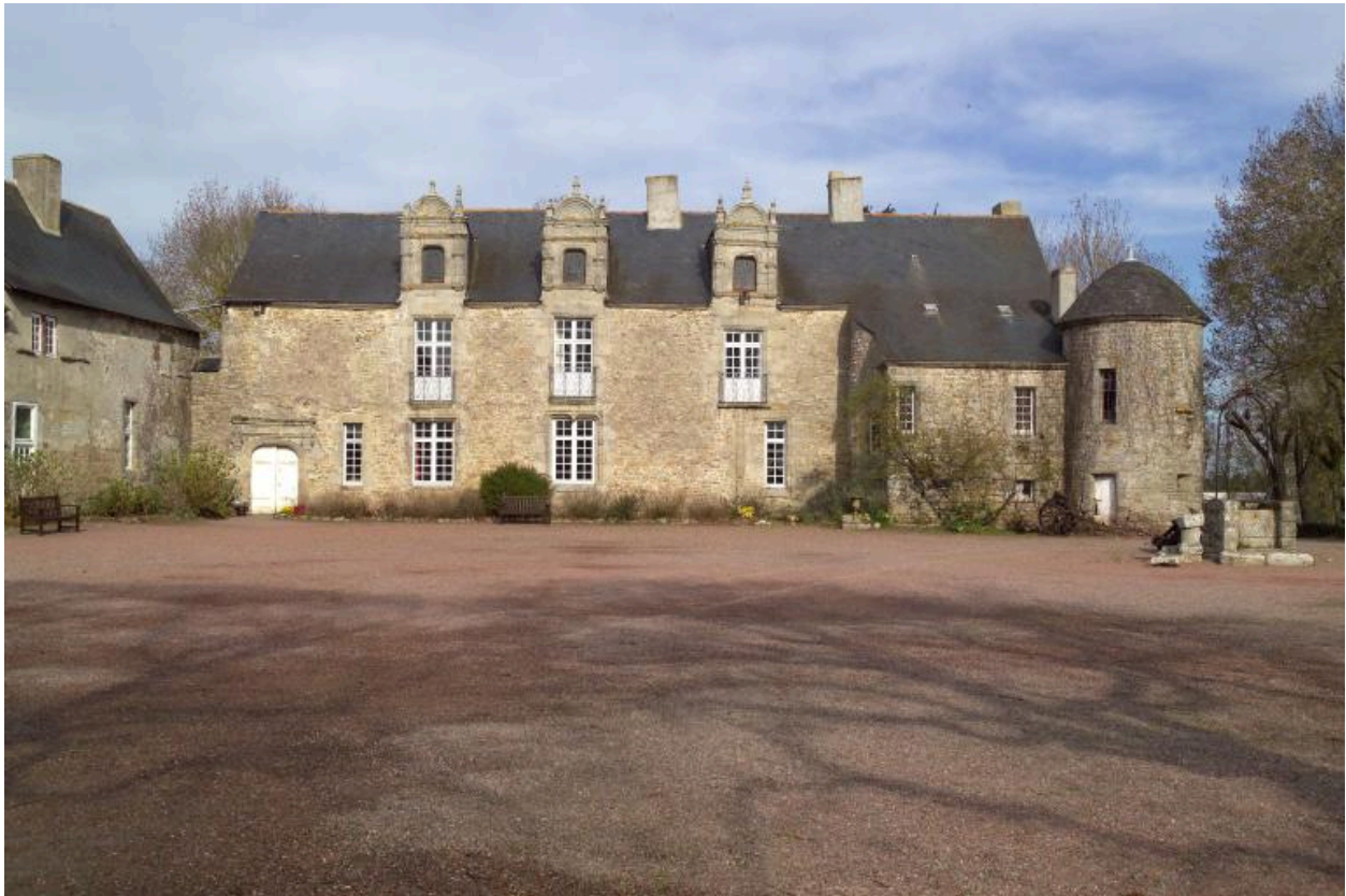
Élévation antérieure du logis.
