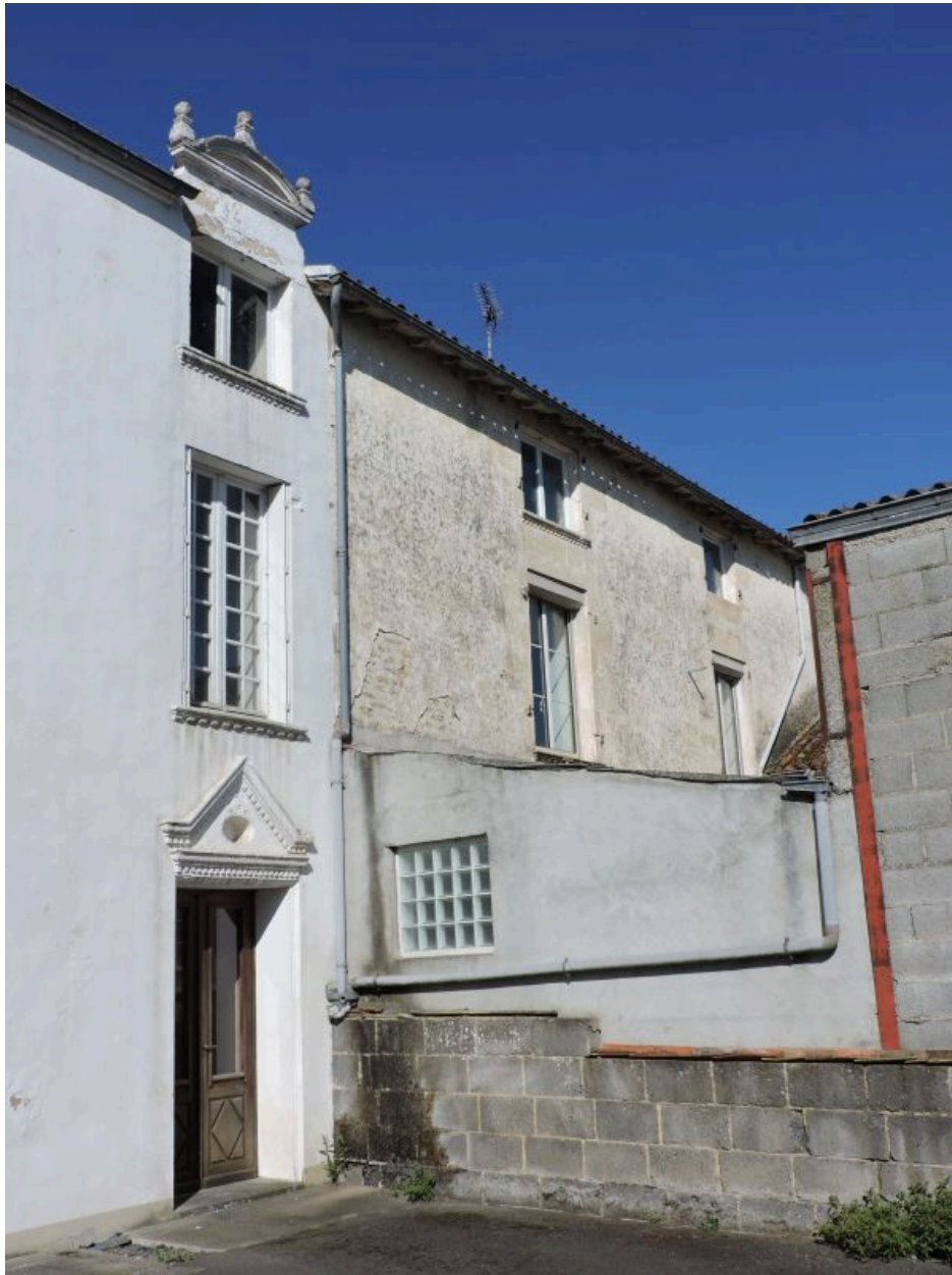
La partie ouest du logis, masquée par l'ancien garage automobile, vue depuis l'est.
