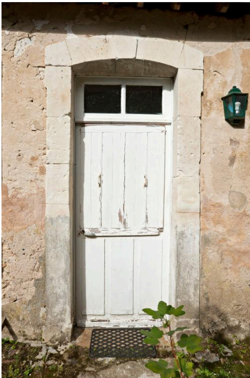
Façade antérieure sur cour : porte d'entrée.
