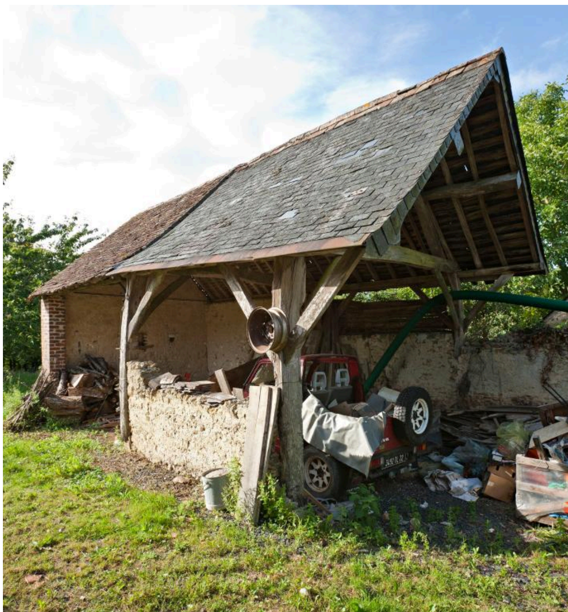
Hangar agricole sur poteaux.
