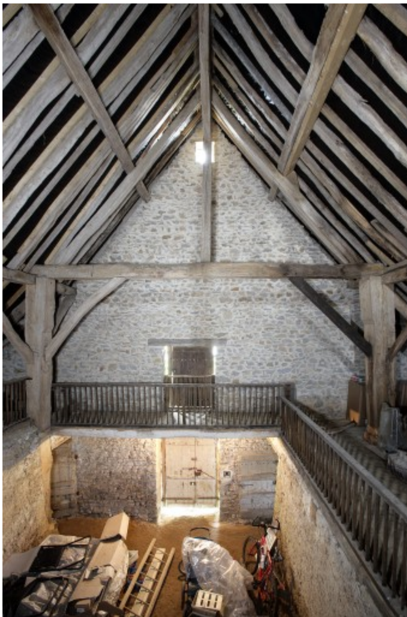
Grange-étable : vue intérieure vers le nord.
