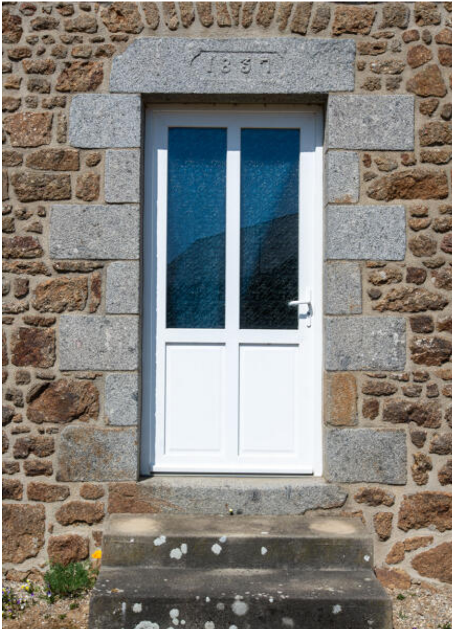
Porte du logis principal, 1837.
