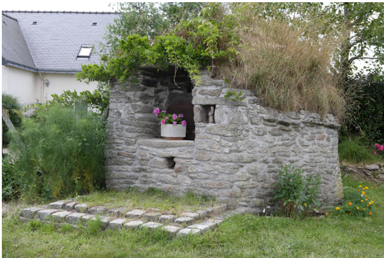
Vue du four à pain.
