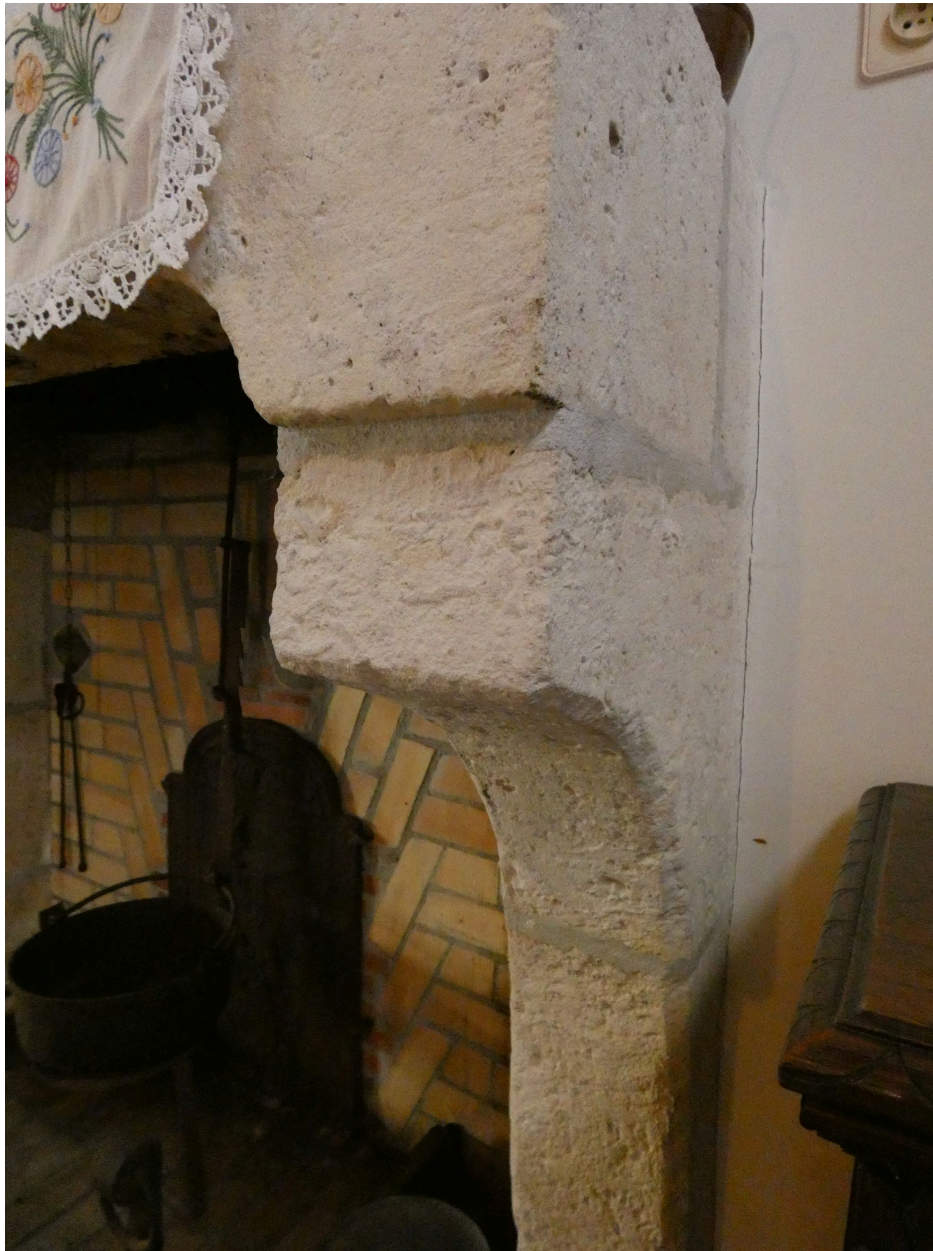
Corbeau de la cheminée.
