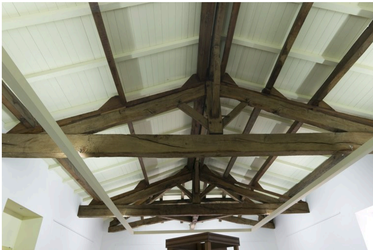
Vue de la charpente des dépendances.
