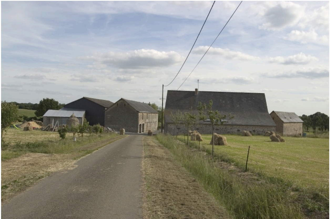
Vue d'ensemble depuis le chemin d'accès au nord : l'étable-grange, le logis, la porcherie.
