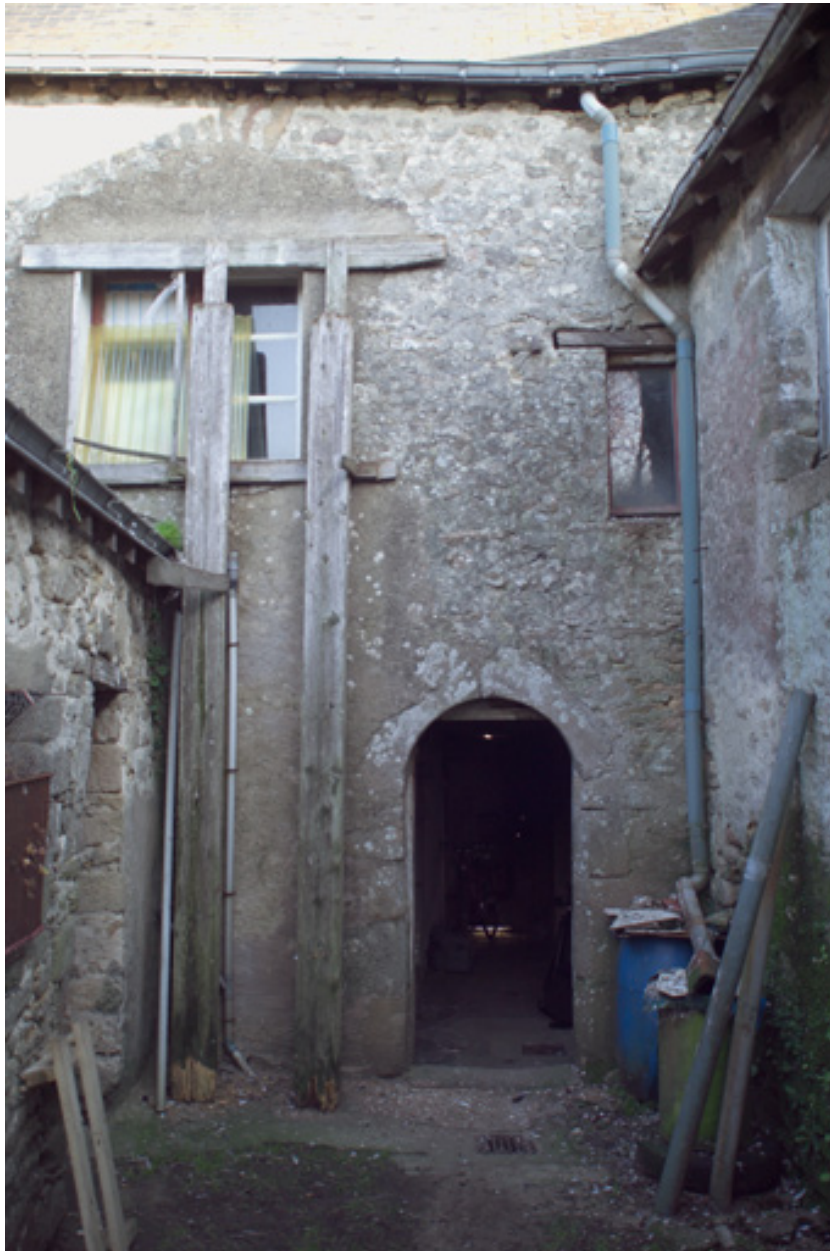
Corps principal, façade sud, porte d'entrée vers le couloir.
