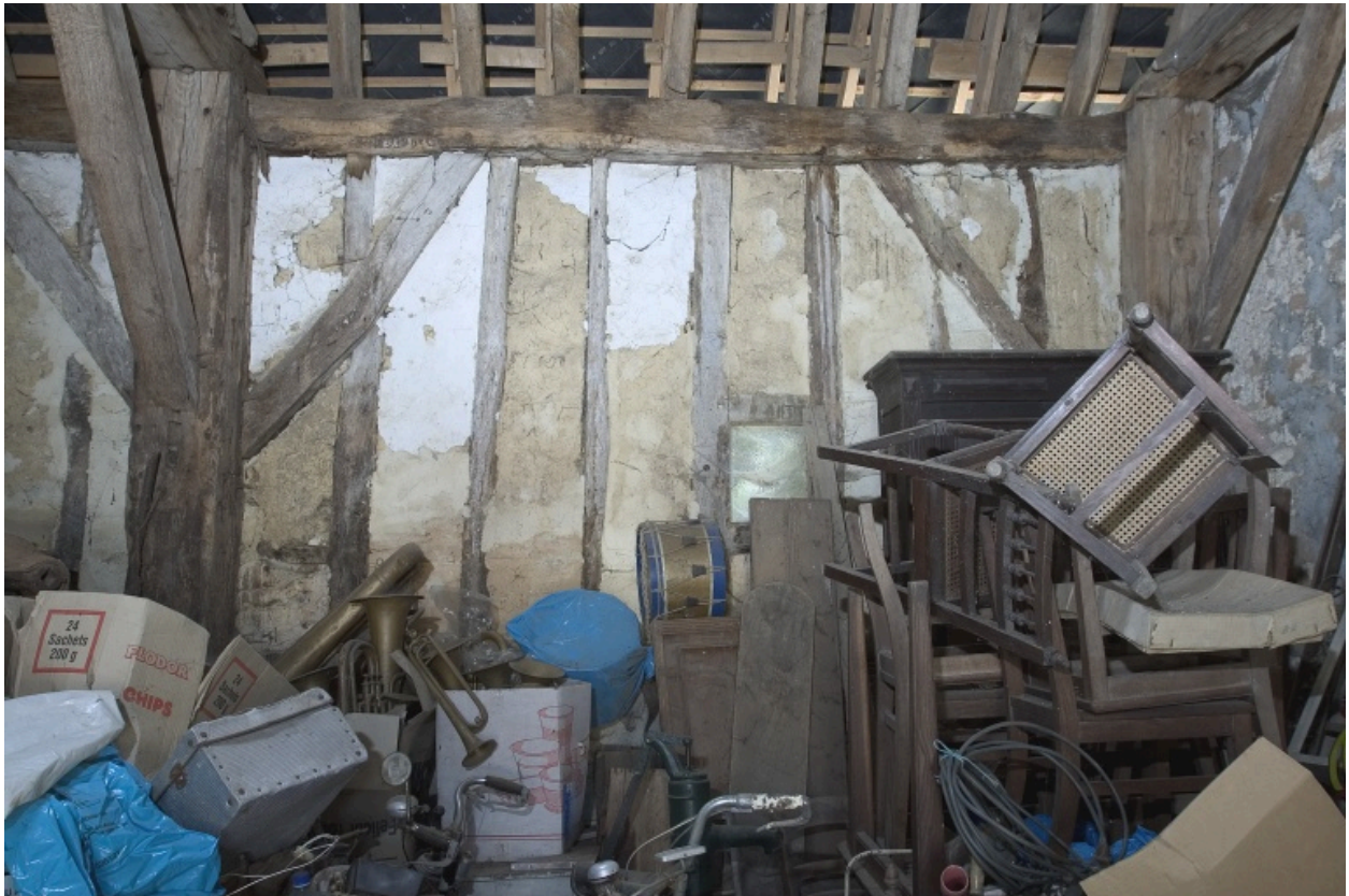
Intérieur de l'étable-grange : mur est de la partie centrale.
