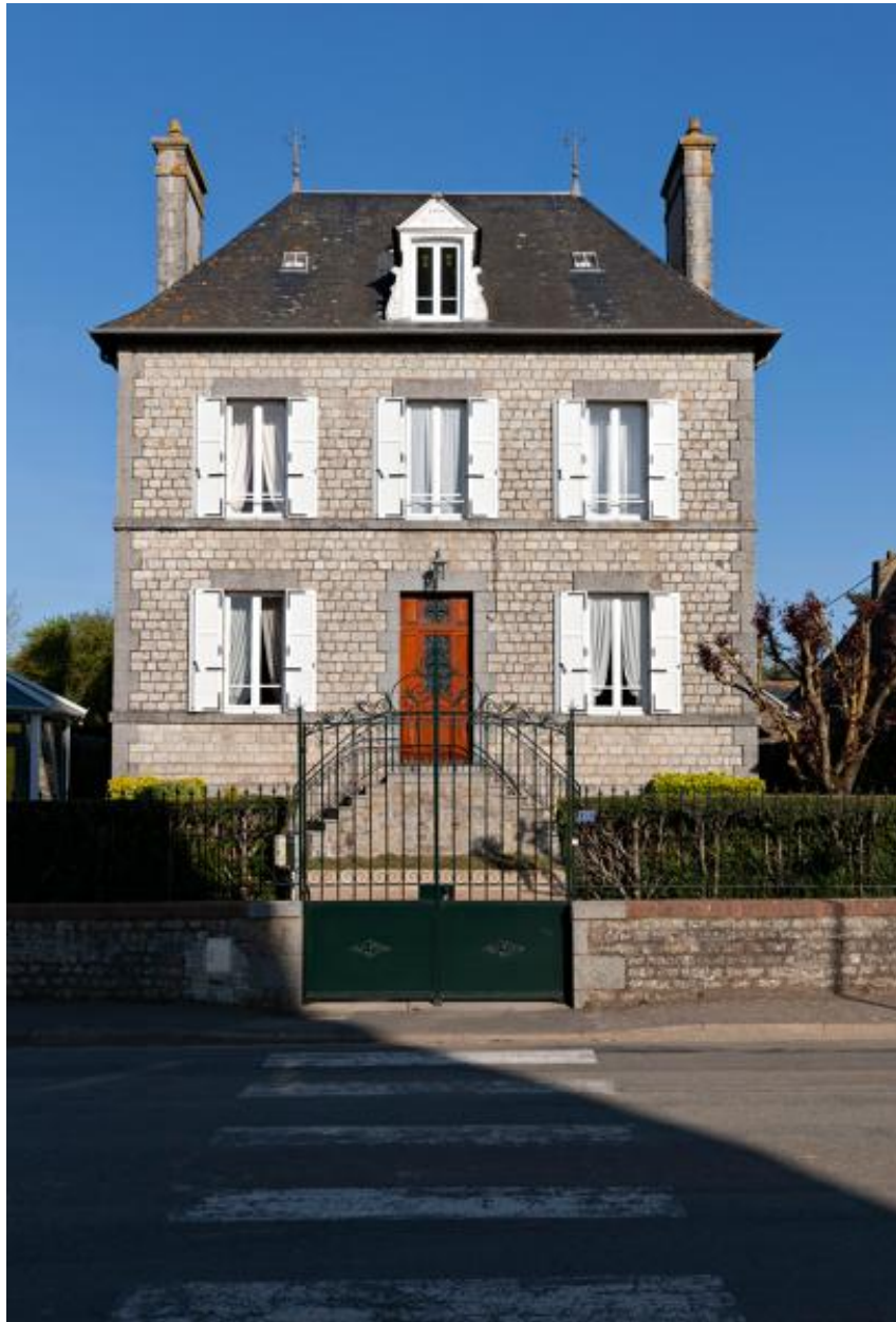
Maison, 23 rue Réaumur.
