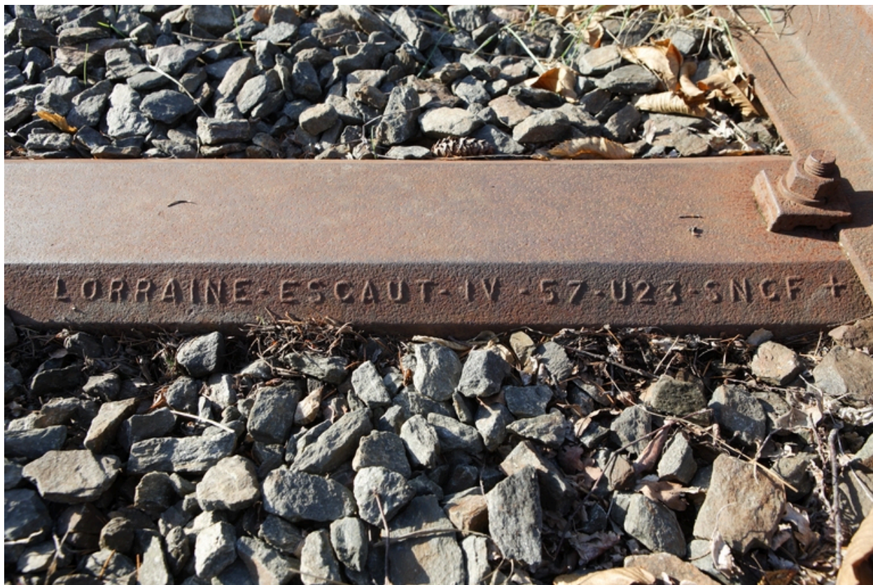
Traverse métallique : inscription Lorraine-Escault 1957.
