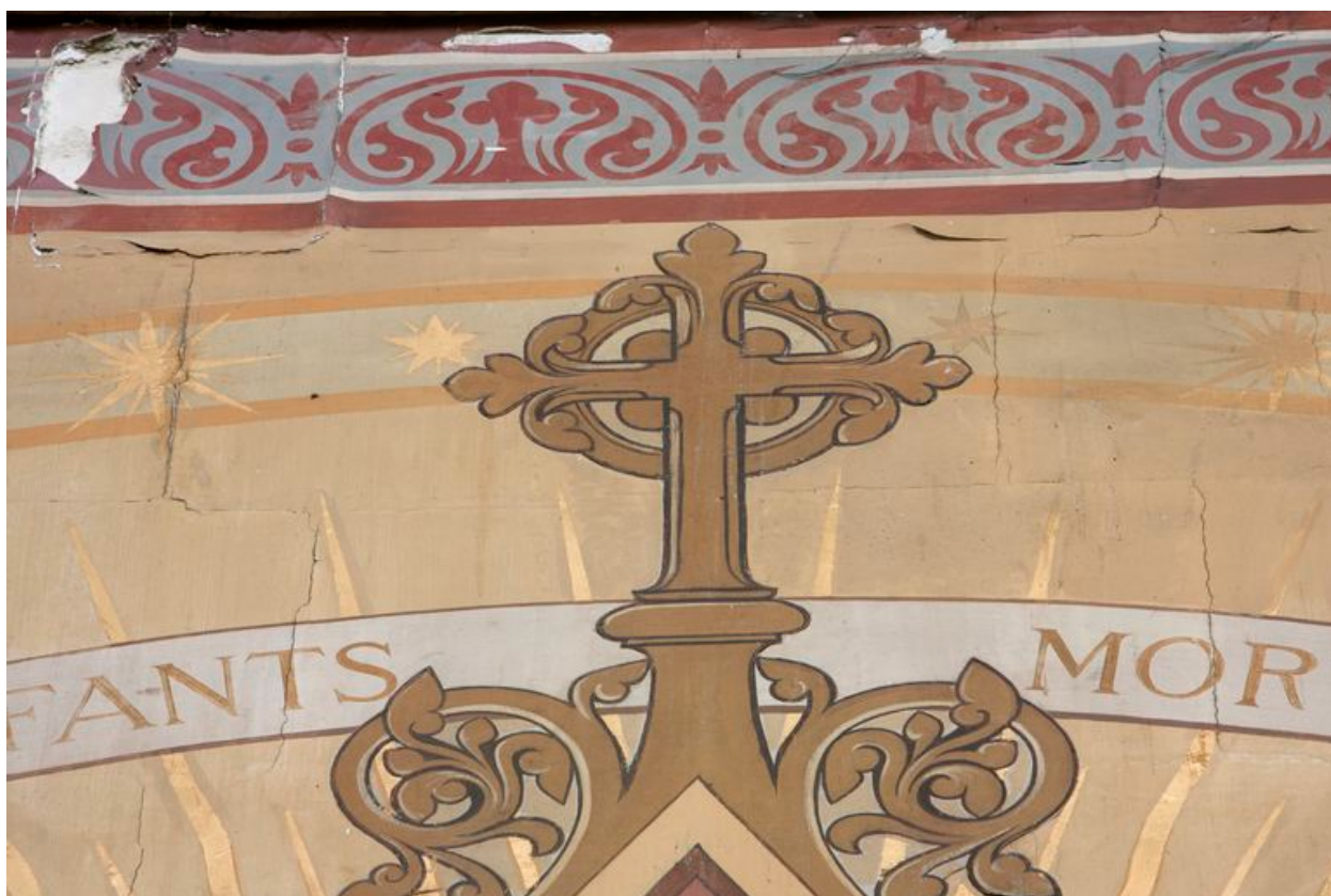
Nef, deuxième chapelle nord. Monument aux morts : détail de la partie supérieure du monument avec la limite entre la toile marouflée et le décor peint directement sur le mur.
