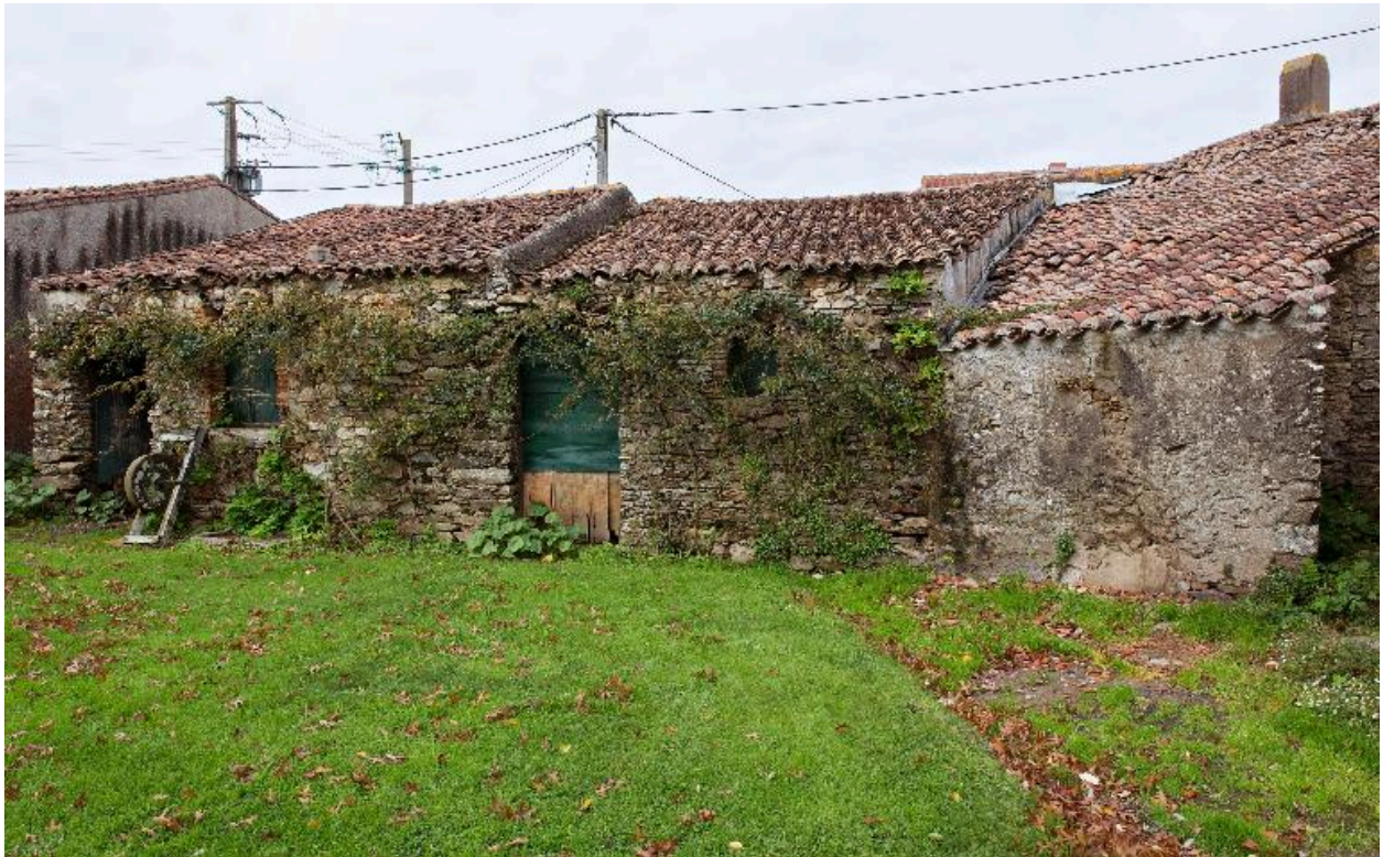
Habitations en bordure du commun, vue des façades arrière (3), HN-303, cadastre 2018.
