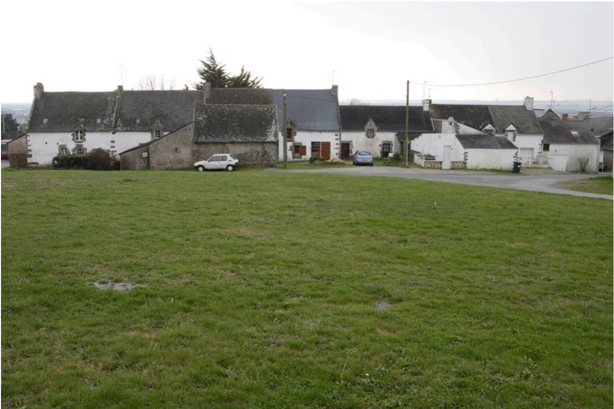
Vue d'ensemble de la rangée depuis le nord.
