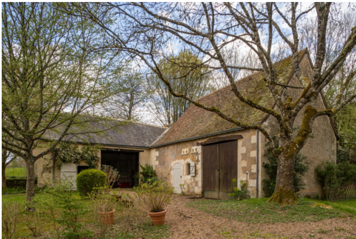
Grange-étable et remise-atelier.
