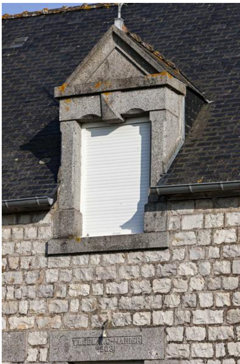
Ferme ouest, détail de la lucarne.
