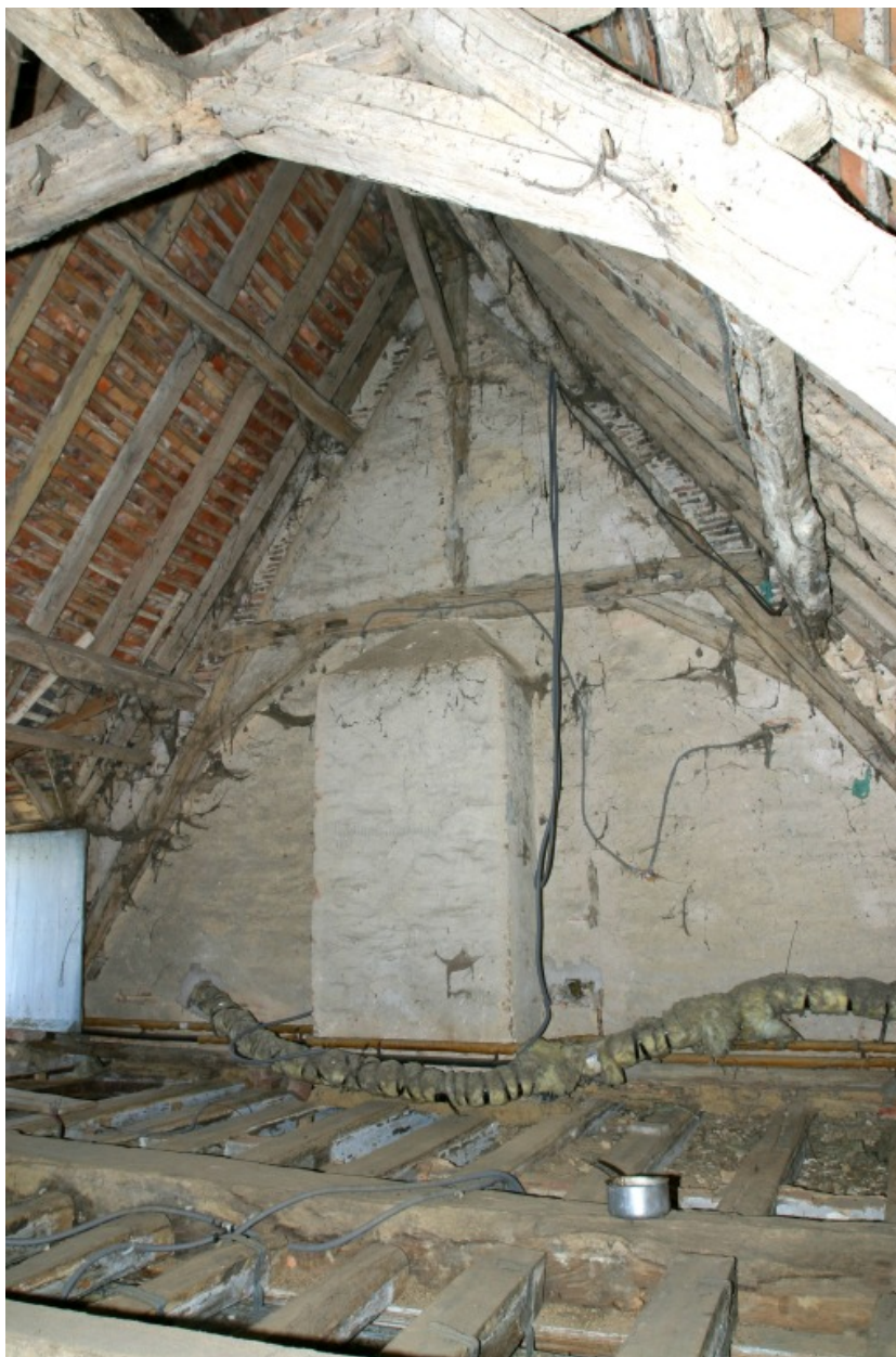
La charpente de la partie ouest du logis, vue depuis l'ouest.
